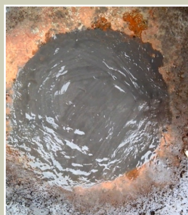
Acabamento com Elastômero proporcionando flexão ao reparo
