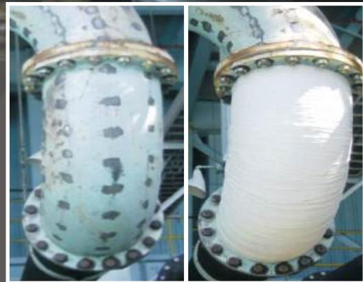
Oferece ótima aderência em metais, aço, aço inox, PVC, FRP, argila (cerâmica), concreto e borracha. Excelente custo-benefício, pois não requer ferramentas para aplicação. A área reparada pode ficar mais resistente que a tubulação original e também pode ser aplicada em superfícies irregulares.
